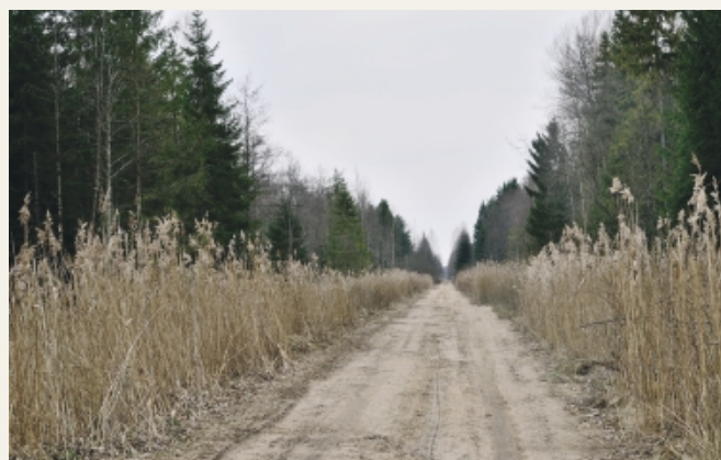
Строительство лесных дорог в труднодоступном лесном фонде
